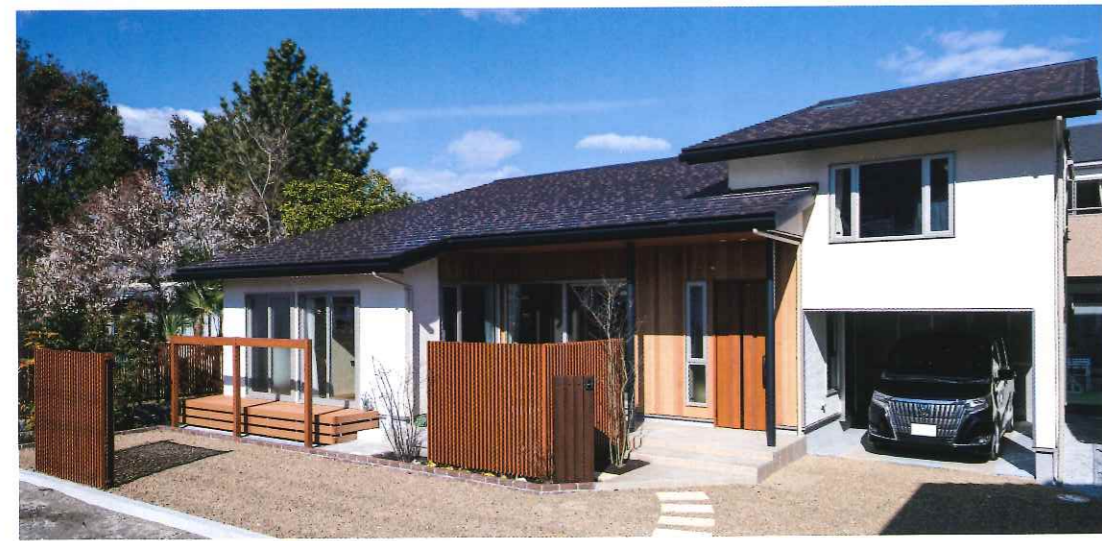
中2階の下に位置するガレージ。シャッターを付けず、外側の壁を開口にすることで床面積に含めなくても済む工夫をし、税金面での負担を軽減。暑い夏のバーベキュースペースとしては絶好の場所だ。 (写真/コンクスハウジング)
